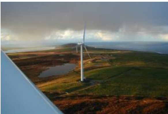
Panoramiche aerogeneratori Parco di Bugar Hill
