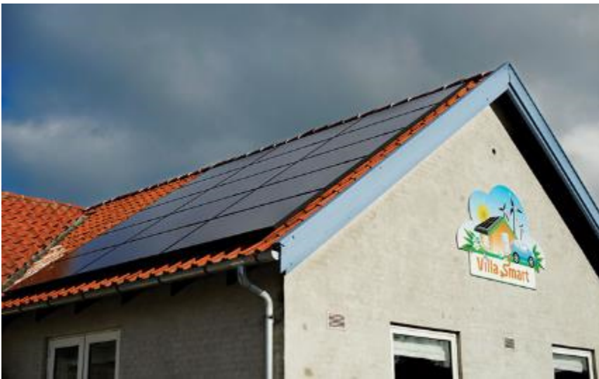
Impianti fv in edilizia pubblica
