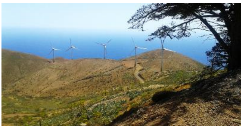
Aerogeneratori della centrale idroeolica
