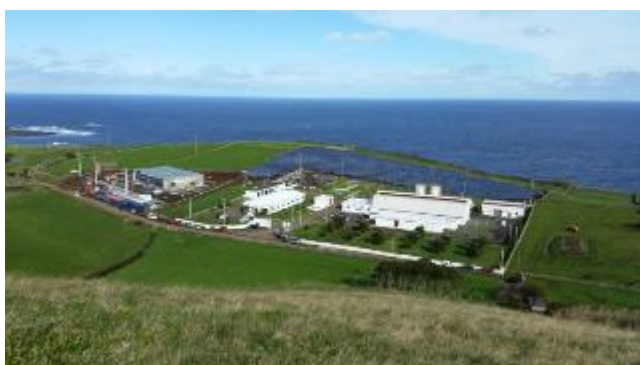
Panoramica impianto fotovoltaico
