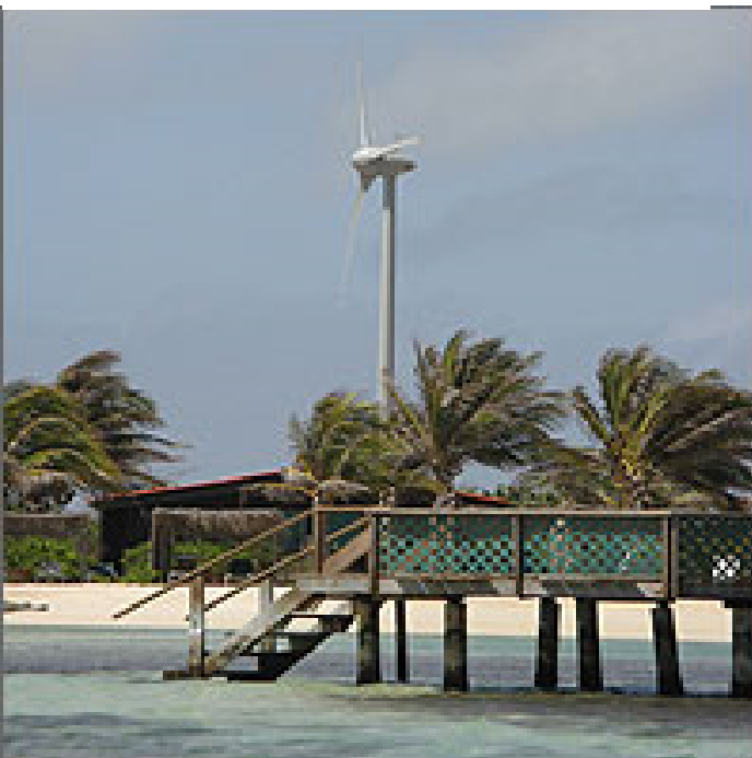
Uno dei 12 aerogeneratori
